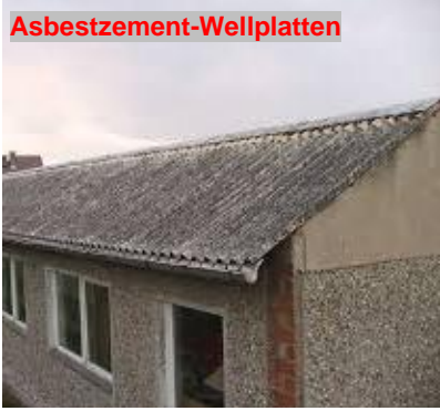
Asbestkunstschieferplatten
